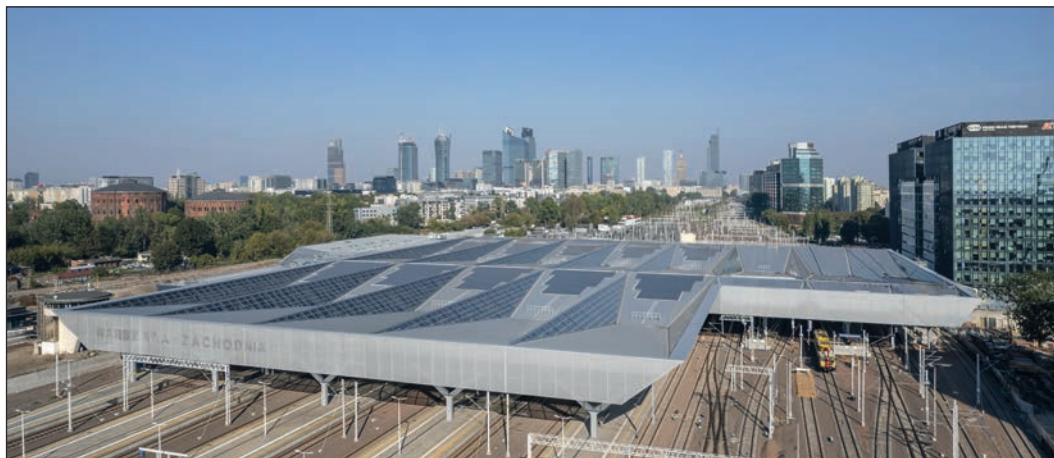
Fot.1. Zastosowane rozwiązania BIPV produkują około 30 % energii potrzebnej do obsługi całego kompleksu komunikacyjnego.
