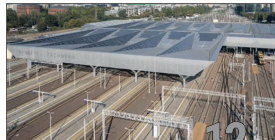
Warszawa Zachodnia ultranowoczesna stacja PKP. Największa instalacja BIPV w Europie
