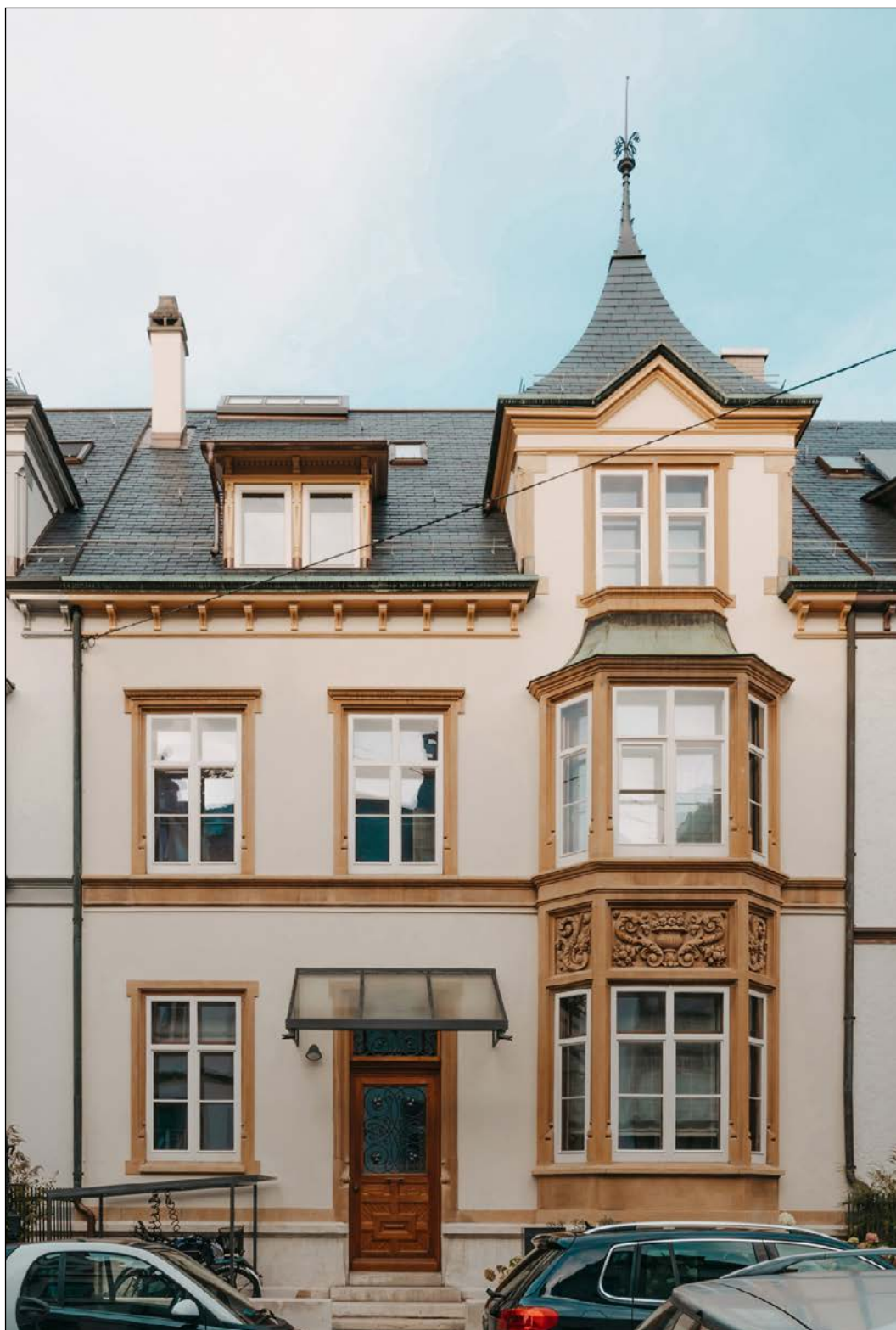
Podczas przebudowy kamienicy w Bazylei zachowano oryginalny wygląd zewnętrzny zabytkowych okien
