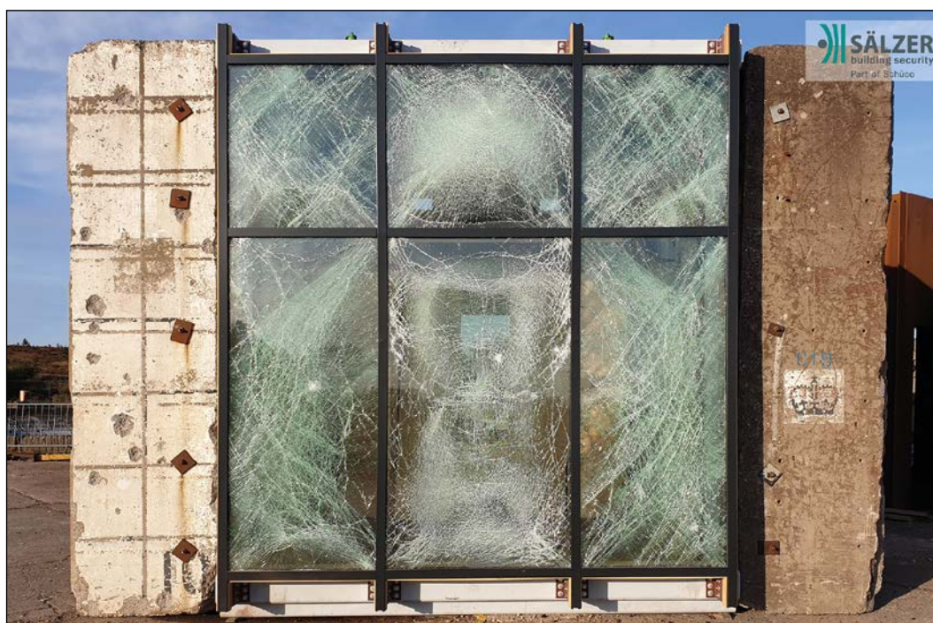
Sälzer jest częścią Grupy Schüco od 2018 roku. Produkty Sälzer są odporne na włamanie, kuloodporne, a nawet odporne na wybuch, co pokazuje ta fasada po eksplozji materiału wybuchowego o masie 500 kg. Fot: Schüco
